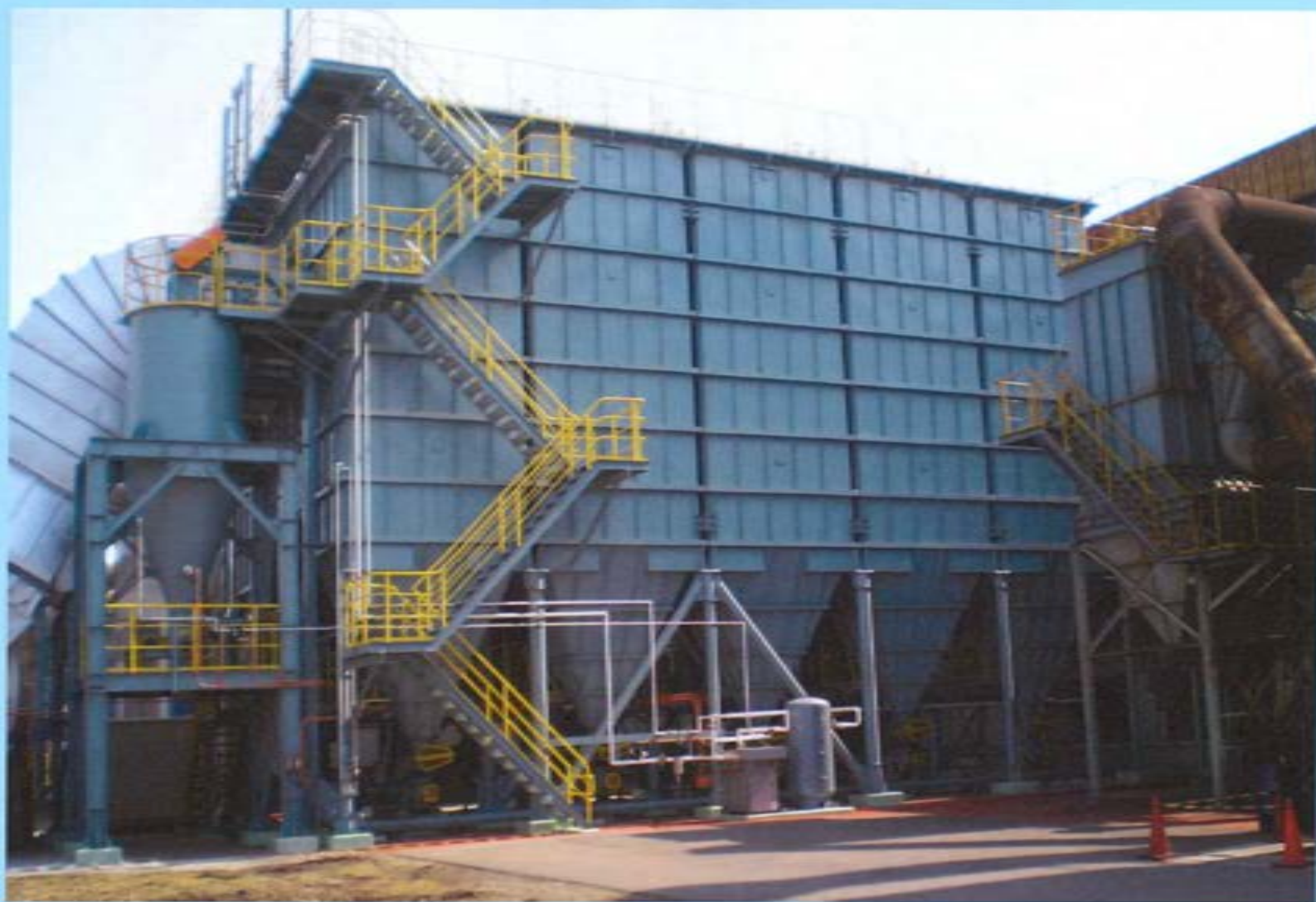
10室バグフィルタ 7,000 m 3 /min 処理
