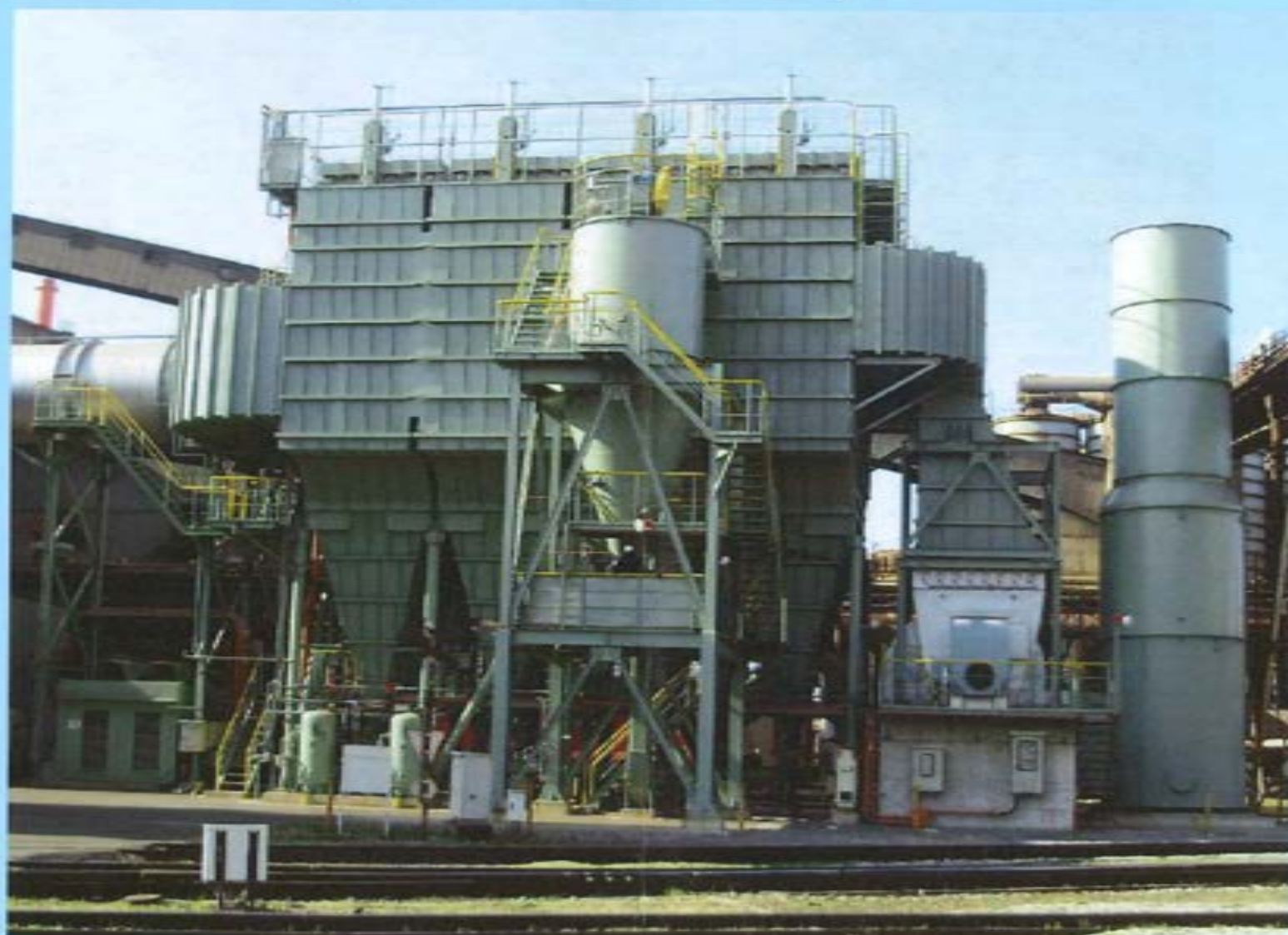
8室バグフィルタ 8,000 m 3 /min 処理
